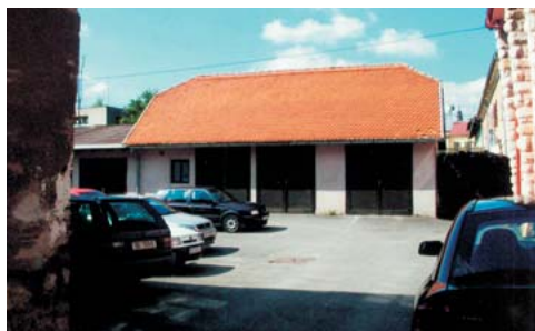
Slika 1. Nekadašnja gospodarska zgrada kuće Ivane Brlić Mažuranić, danas garaža Hrvatskih šuma
