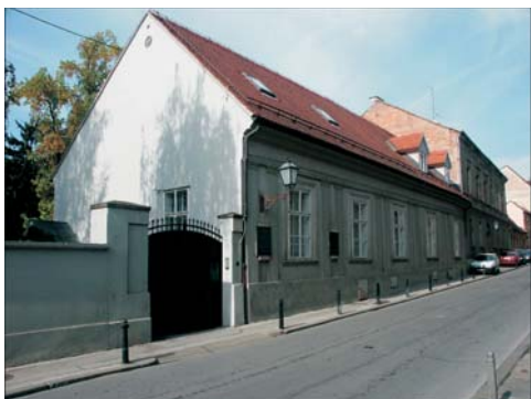
Slika 3. Zgrada obitelji Mažuranić u Jurjevskoj ulici, danas Španjolska ambasada
